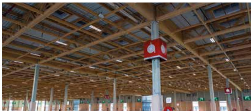
▲ La charpente du hall 3 du parc des Expositions du Bourget est destinée à rester visible.
