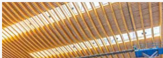
Photo : Bouygues Bâtiment Île-de-France – Potion Médiatique/Elise Robaglia ; architectes : Ateliers 2/3/4/ & VenhoevenCS
